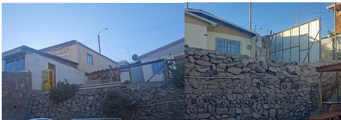
Foto acceso de salida 2.do piso desde el gimnasio hacia una puerta metálica que conduce al exterior.
